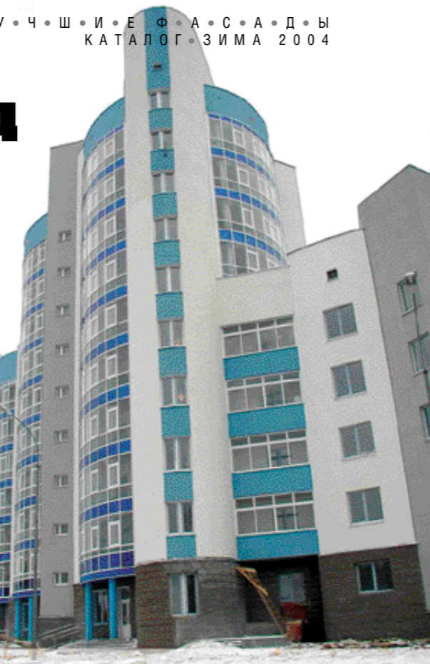
Екатеринбург. Комплекс по ул.Шевелева. Система наружной теплоизоляции Ceresit WM 100 мм Декоративная отделка Ceresit CT36
