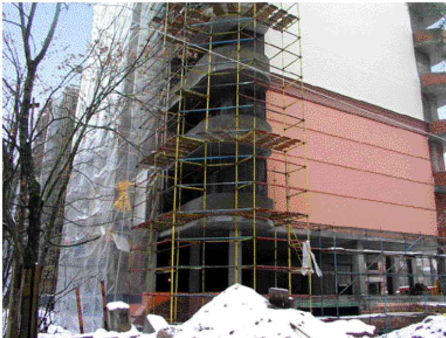
Тепловой контур или «Тепляк» представляет собой систему прочных усиленных полиэтиленовых покрытий закрепленных на фасадных строительных лесах универсальной крепежной системой
