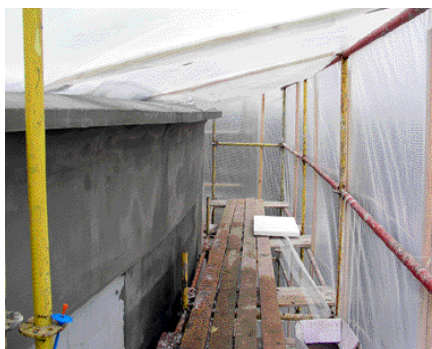
Тепловой контур или «Тепляк» представляет собой систему прочных усиленных полиэтиленовых покрытий закрепленных на фасадных строительных лесах универсальной крепежной системой
